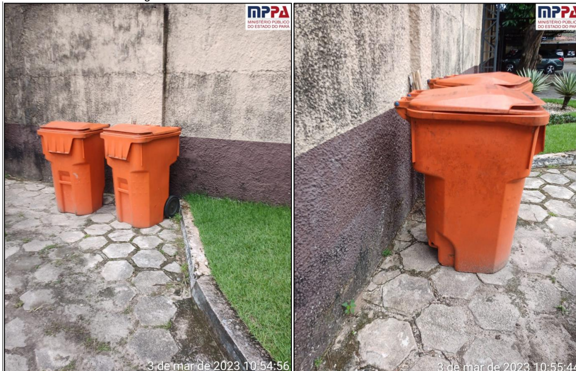
Figura 9 – Acondicionamento externo dos resíduos sólidos.
